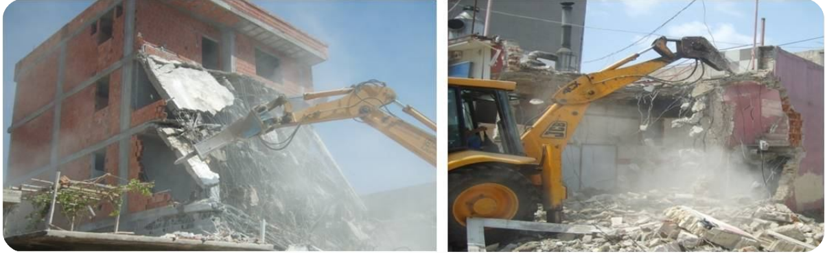
Resim 16. Kaçak yapı yıkımı
