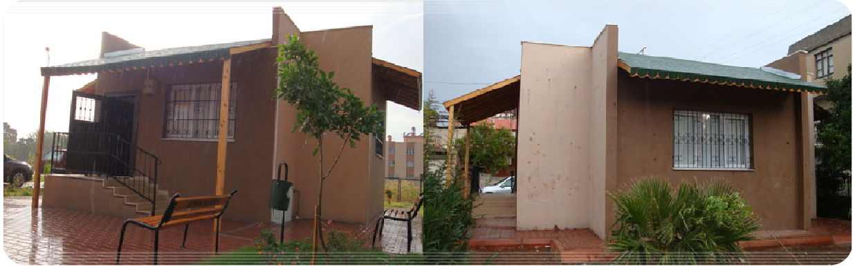
Resim 7. Muhtarlık binası yapımı
