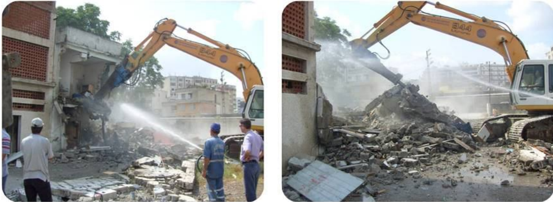
Resim 17. Kaçak yapı yıkımı
