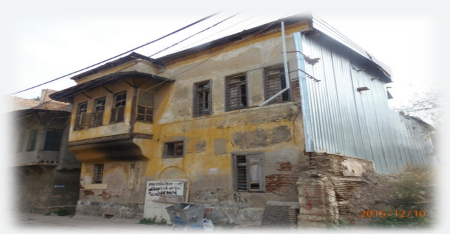
98 Envanter No'lu Yapı (Vehbi Necip Savaşan Evi)
